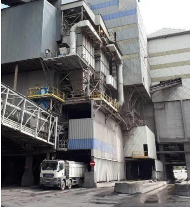
Bâtiment Granulats –Filtres F17 et F18
